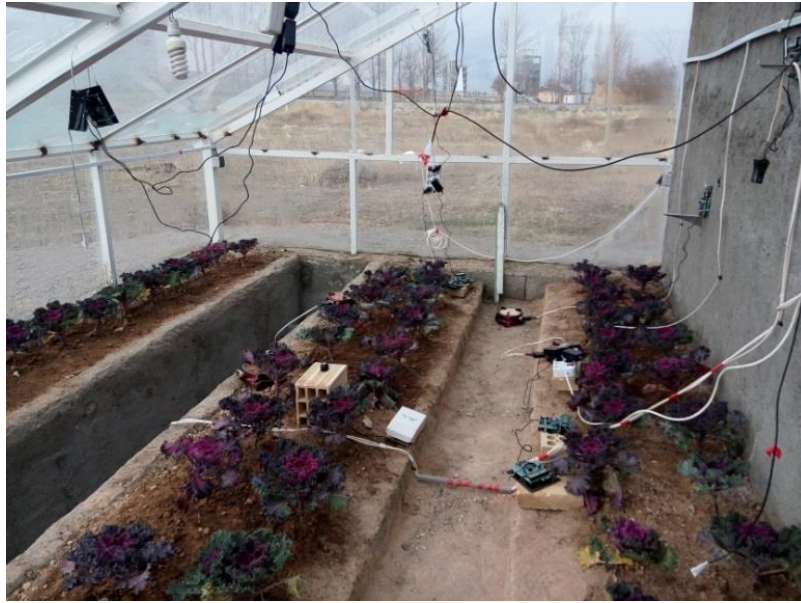
Fig. 2. Location of temperature and relative humidity sensors installed at the greenhouse شکل ۲: موقعیت سنسورهای SHT11 و TES1333 نصب شده در گلخانه
