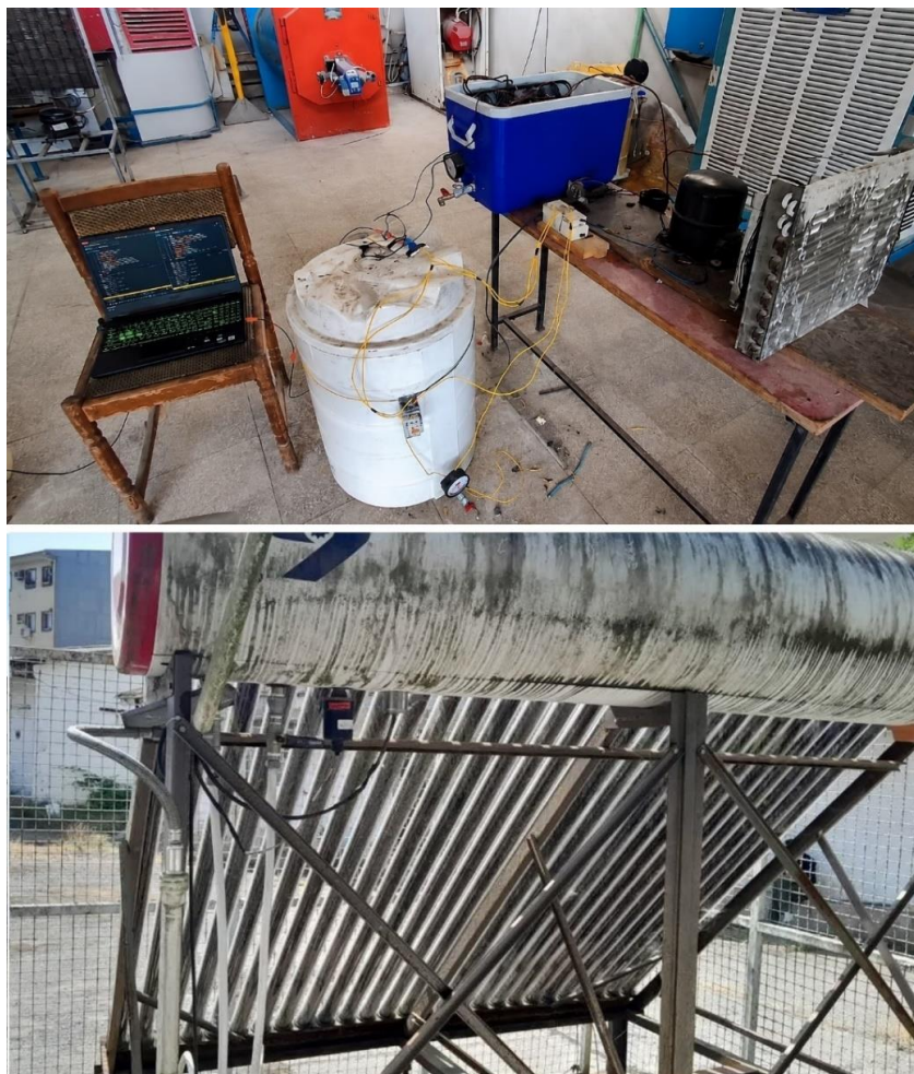
شکل ۱. سیستم پمپ حرارتی خورشیدی انبساط مستقیم ساخته شده.
