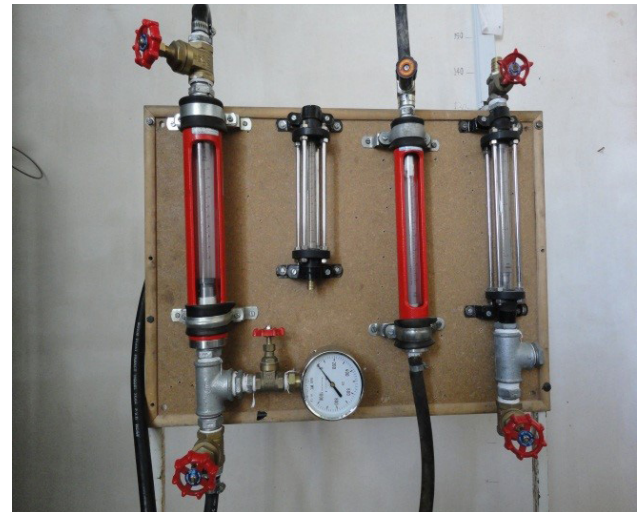
شکل ۱: روتامترهای هوا و سوخت
